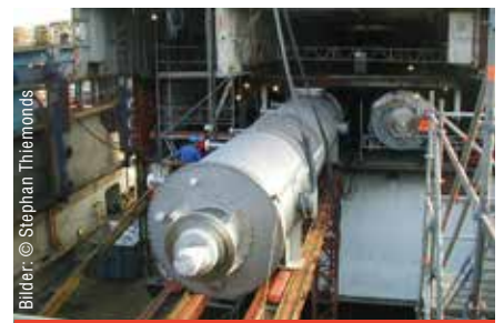
Einbau von zwei Buss-SMS-Canzler Krill-Trocknern durch das aufgeschnittene Maschinendeck.
