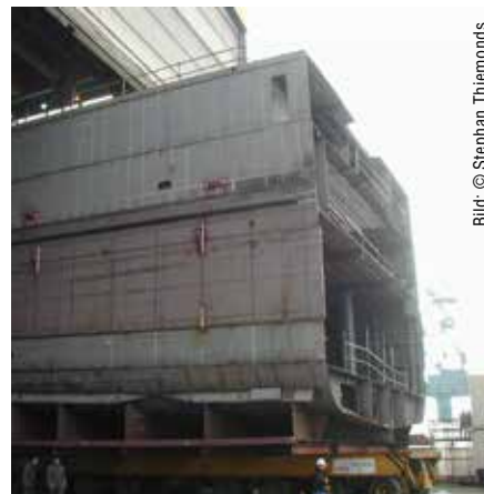
Die beiden vorgefertigten, insgesamt 28 Meter langen Schiffsrumpfmittelstücke.
